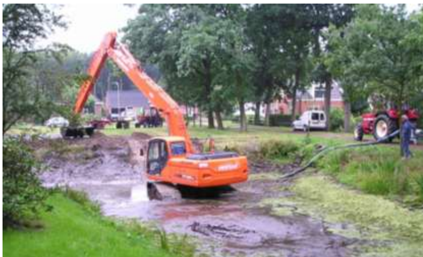
Figuur 7.2 Het leegpompen en vervolgens baggeren van de vijvers heeft de voorkeur.
